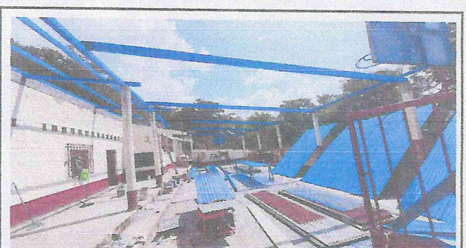
Foto 4: Emparejado de Techos Aulas y cancha.
