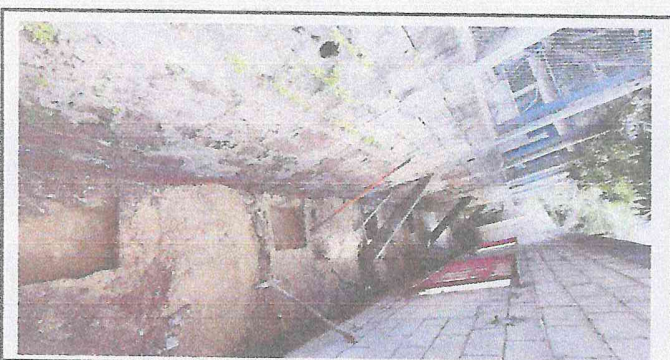
Foto 5: Perforación para colocar columnas de refuerzo.
