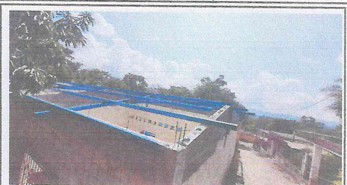
Foto 2: sustitución de estructura metalica Pintada y soldada.
