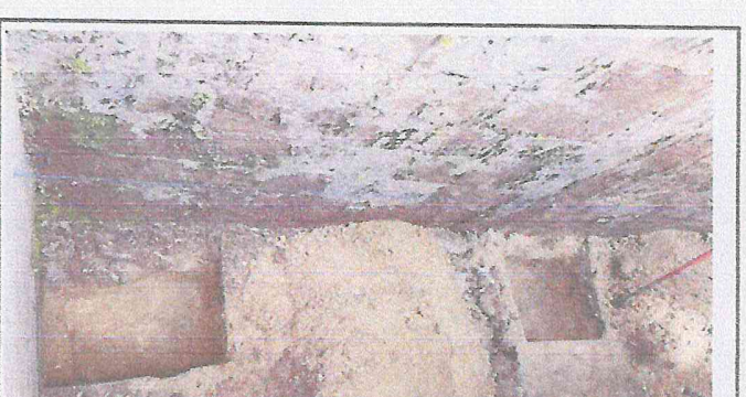
Foto 6: Reforzamiento de muro con columnas extras reforzadas.
