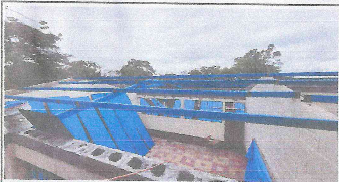
Foto 3: Pintado de Laminas y estructura.
